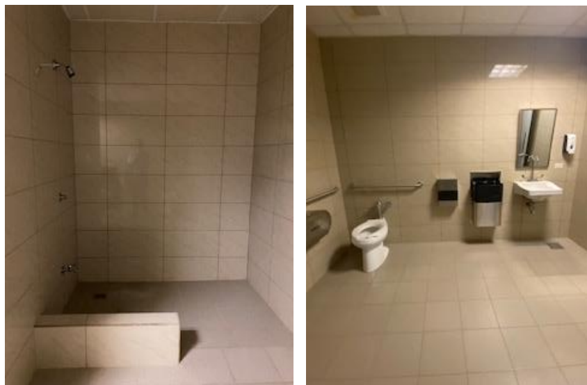
Fotos: Baño de los dormitorios para personas en condición migratoria especial.
